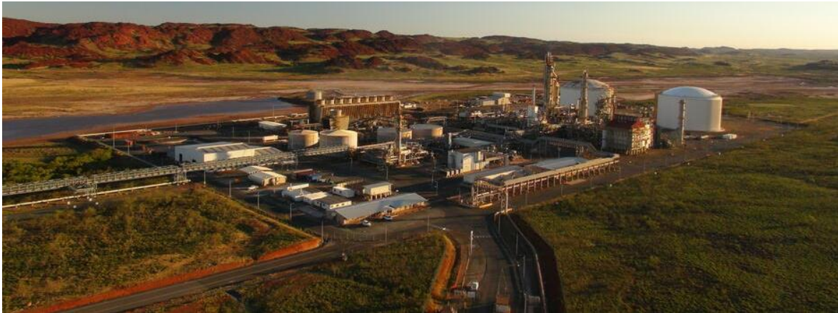
Figura 28: Planta de generación de fertilizantes de Yara Pilbara. Fuente: (Yara, 2020).
